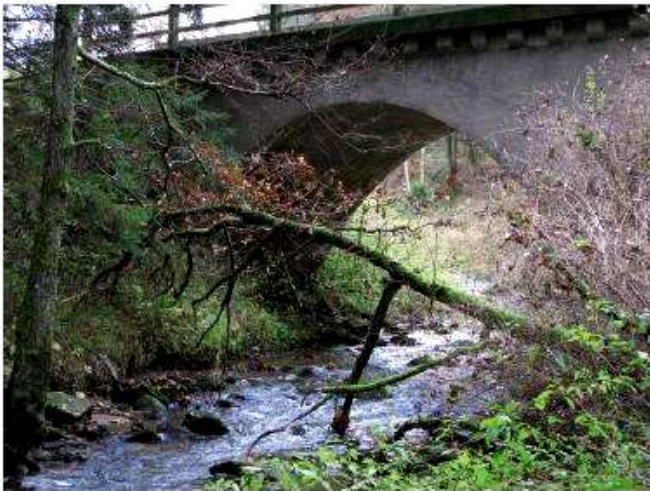
Bahnbrücke über den Wenzenbach
