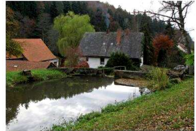
Mühle am Schönberg: Die Getreidemühle brannte 1956 ab. Heute wird mit einer Turbine Strom erzeugt (Gefälle 7,8 m, ca. 3 kW elektrische Leistung).
